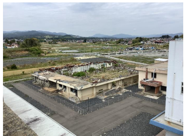
*屋上から見える被災した体育館(屋内運動場)
